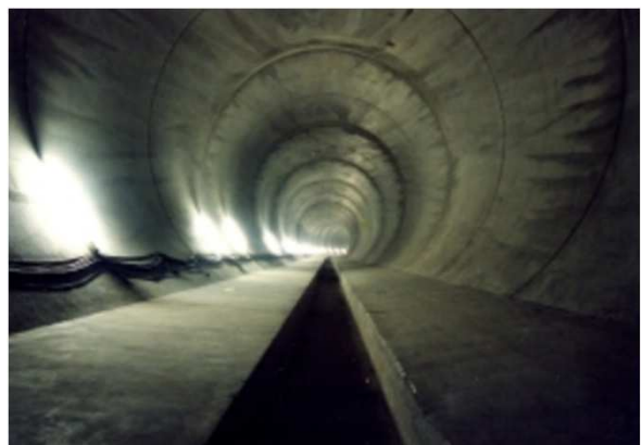
江川雨水貯留管
