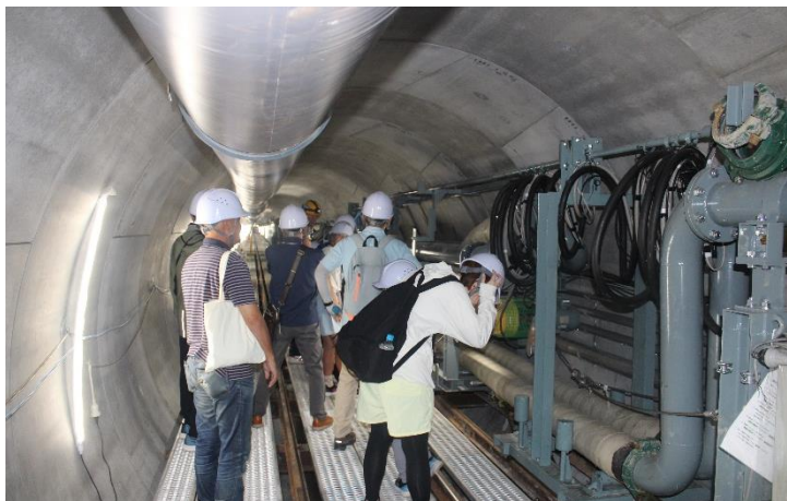
トンネルの建設現場
