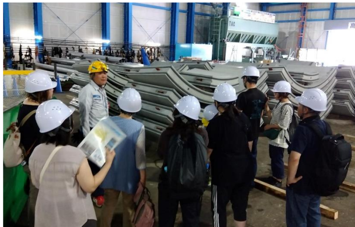
組立前のセグメント（トンネルの壁面）
