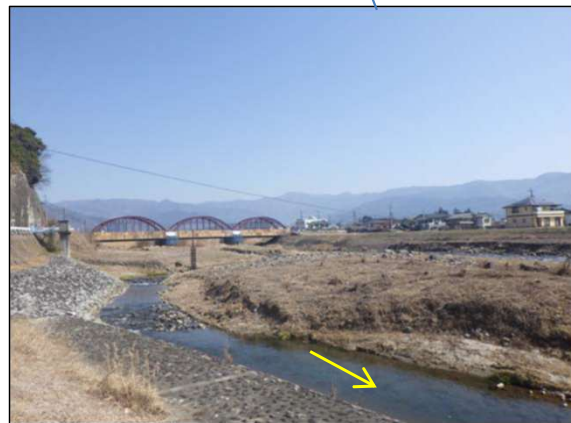
2023年3月8日 亀甲橋地点
