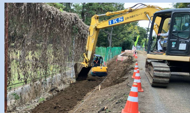
段切りによる堤防整備の 準備をしています。(令和6年11月)
