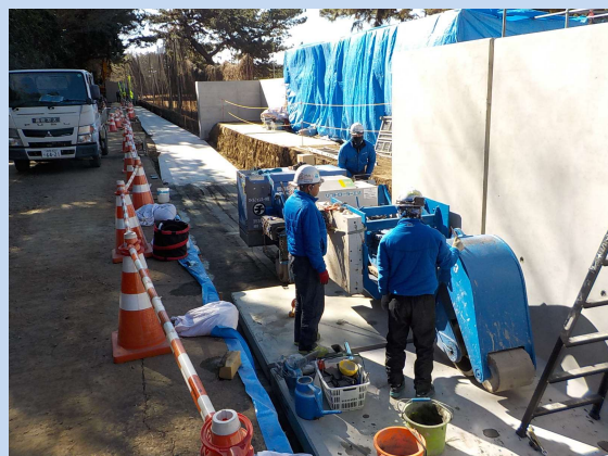
擁壁を設置しています。 (令和7年1月)
