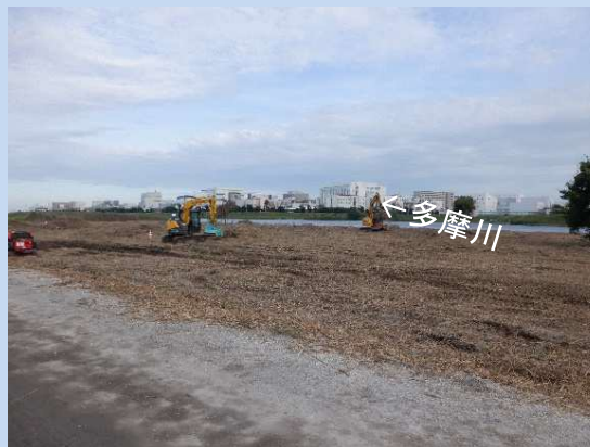
工事に入る準備をしています。 (令和6年10月)
