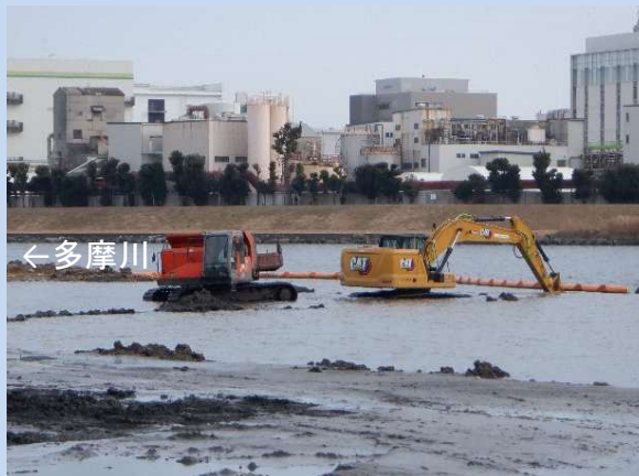
河道を掘削しています。 (令和7年1月)
