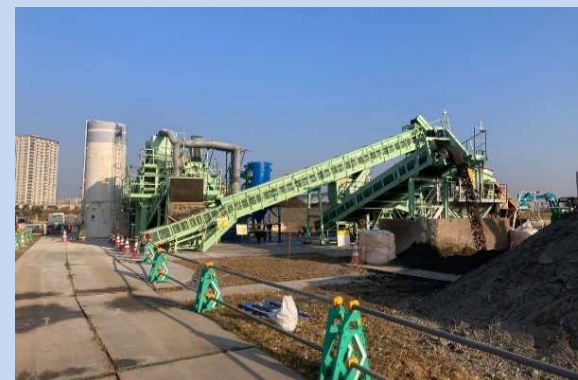
土砂分別を行っています。 (令和6年12月)
