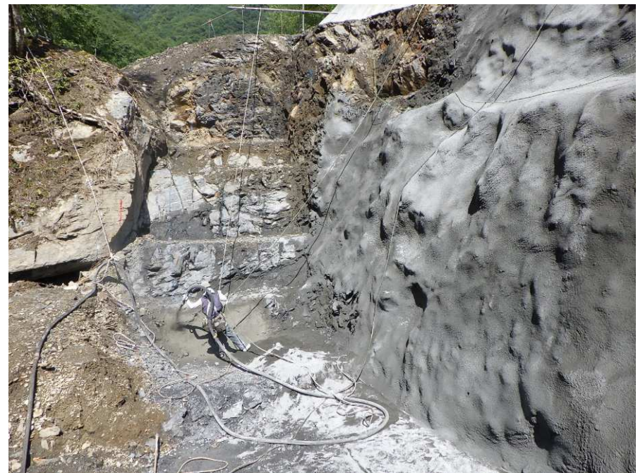
【モルタル吹付工 施工状況】
