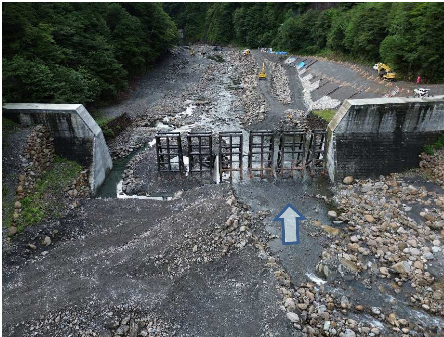
【上流側上空より施工箇所を望む】
