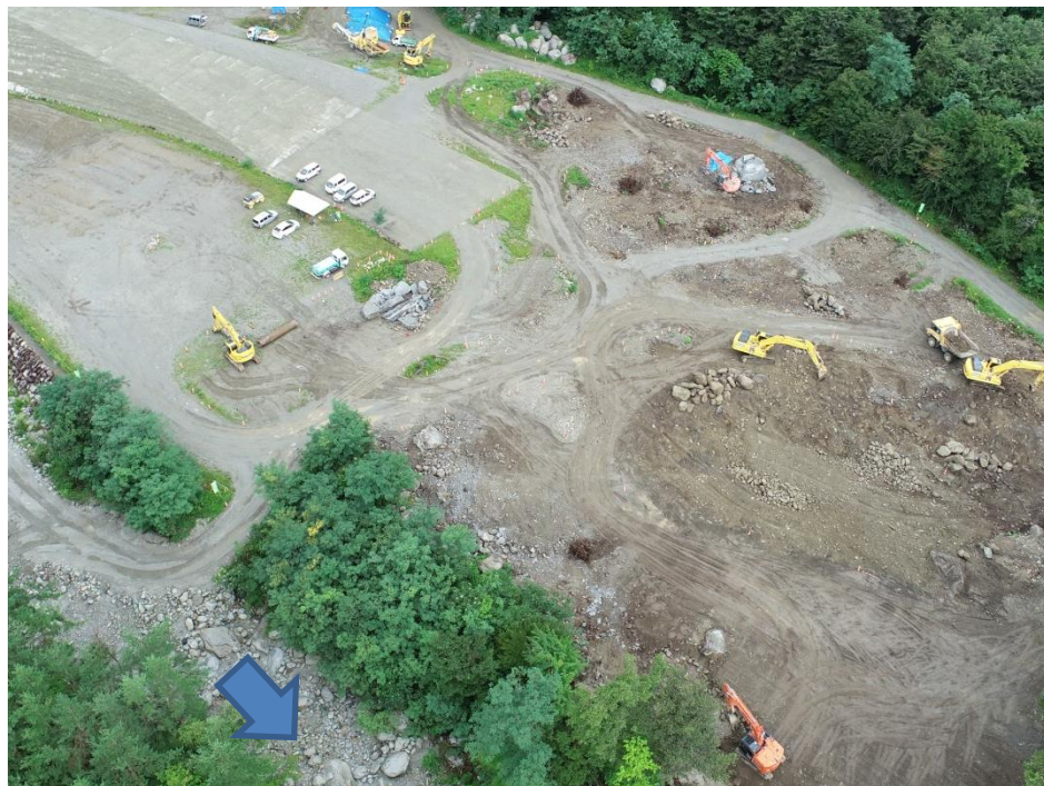
導流堤工 作業土工 床掘(掘削(砂防))
