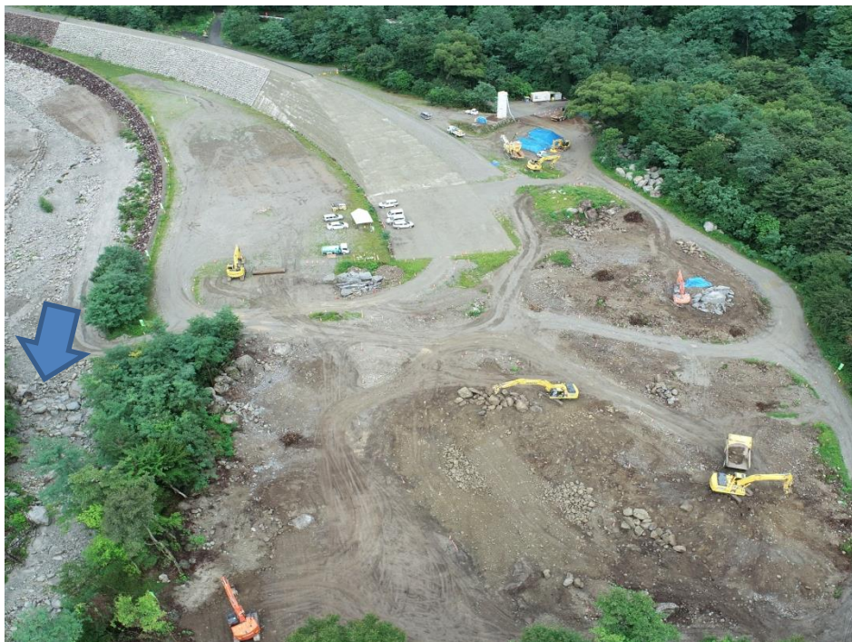
導流堤工 作業土工 床掘(掘削(砂防))
