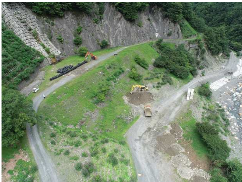
根固めブロック制作場所 整備
