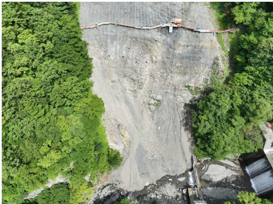
上空より施工箇所を望む
