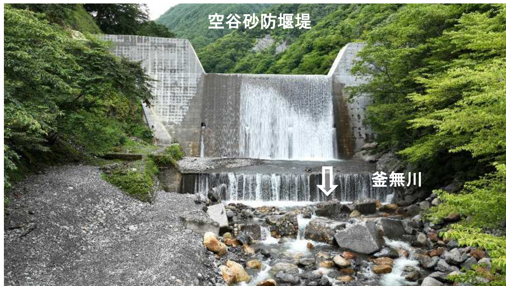
【着手前】下流より副堰堤を望む
