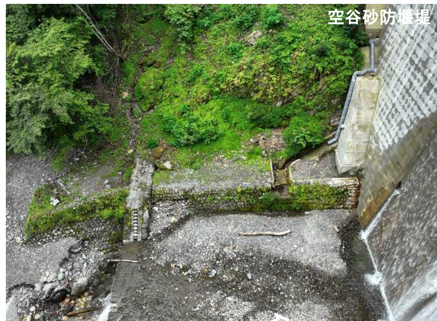
【着手前】左岸上空より側壁工施工箇所を望む
