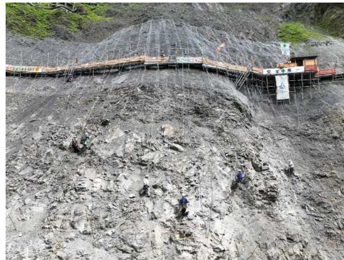
落石雪害防止工 アンカー削孔設置
