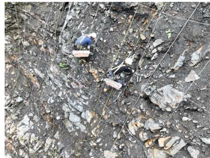
落石雪害防止工 アンカー削孔設置
