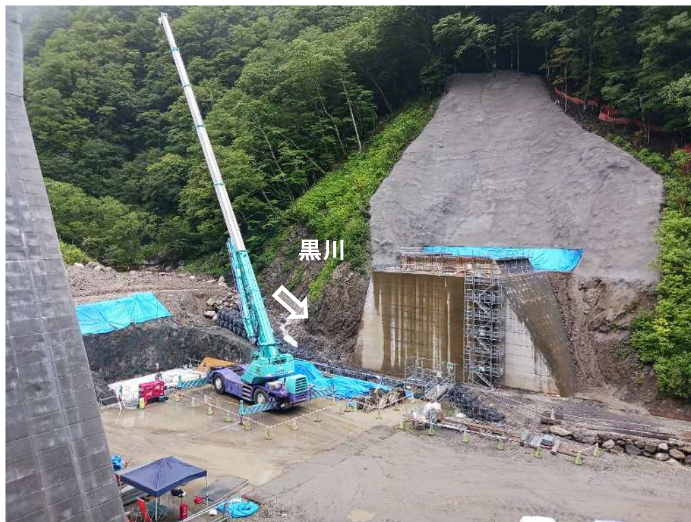
下流 右岸より本堰堤を望む（コンクリート堰堤工）
