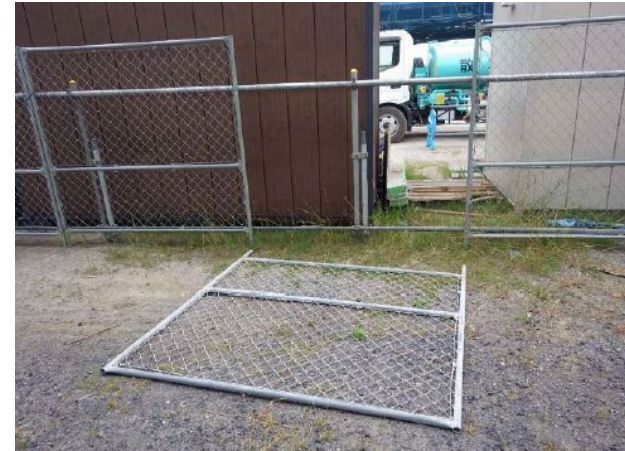
(仮囲いフェンス)
