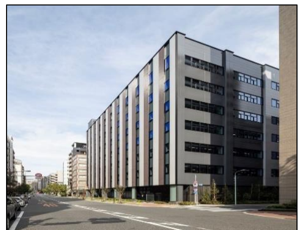
②平成通りから見た庁舎
