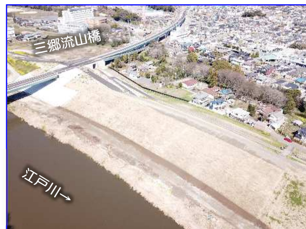
R4江戸川左岸三輪野山地先堤防整備工事 【流山市内の堤防整備工事】
