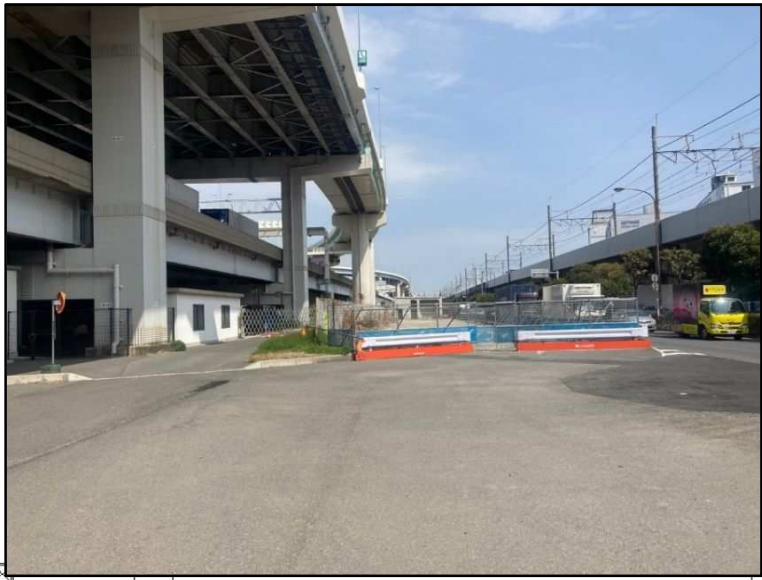
① U型擁壁（UU-6）
