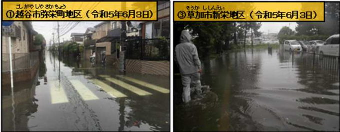
令和5年6月台風第2号による被害
