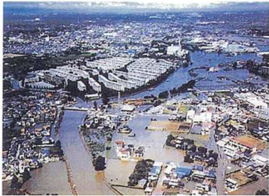
昭和61年8月洪水による被害 （越谷市）
