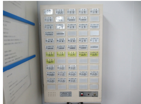
図2 事務庁舎棟（副受信機）
