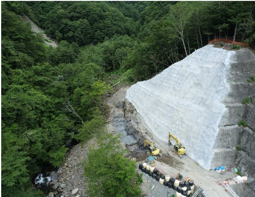
【下流側上空より施工箇所を望む】
