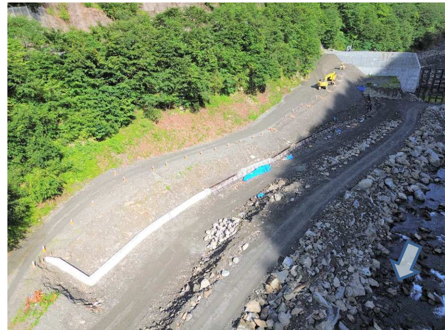
【下流側上空より管理用道路施工箇所を望む】
