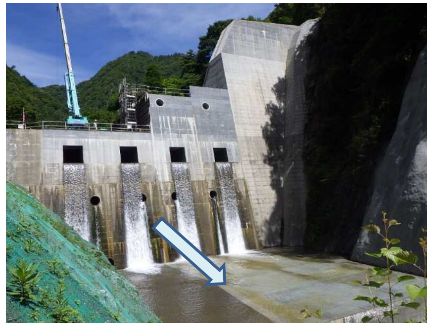
右岸下流側より望む
