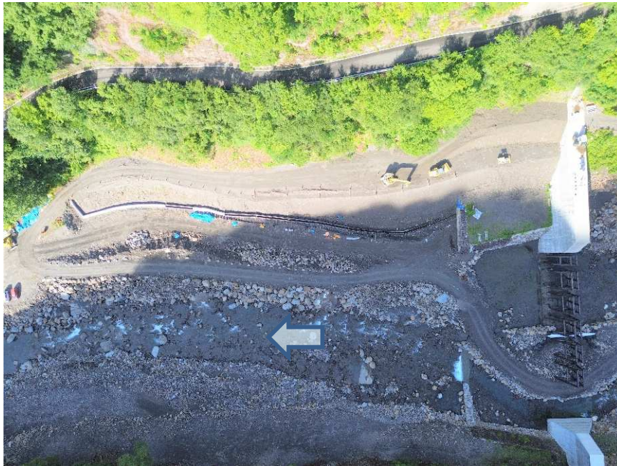
【上空より施工箇所を望む】
