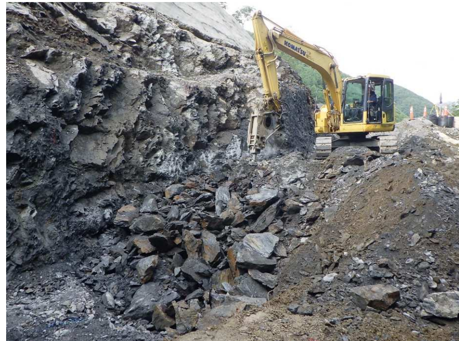
【施工(掘削)状況】
