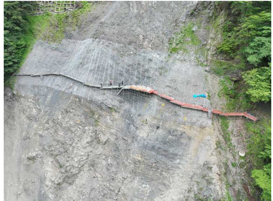
仮設工 作業通路設置
