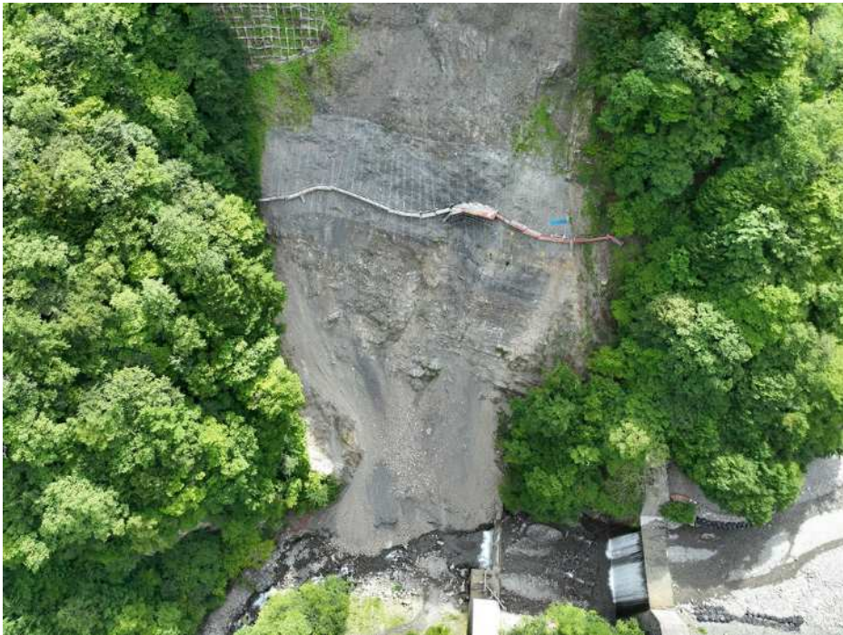
上空より施工箇所を望む
