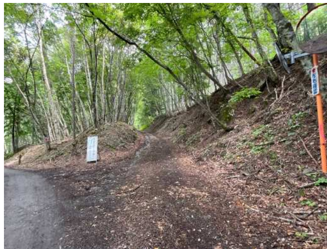
【着手前】 コンクリート舗装工 施工区間②
