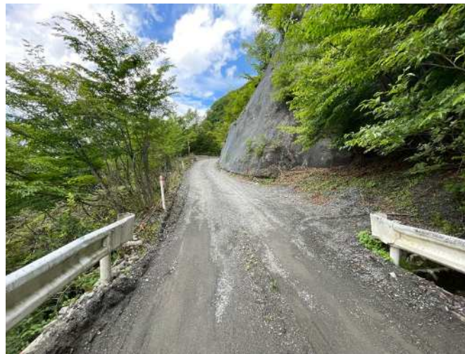
【着手前】 コンクリート舗装工 施工区間①
