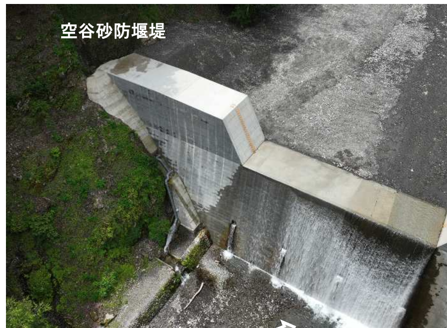
下流上空より本堰堤を望む（コンクリート堰堤工）
