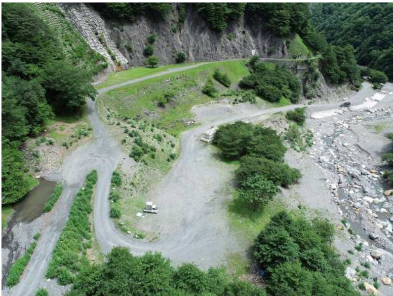
【着手前】根固めブロック制作
