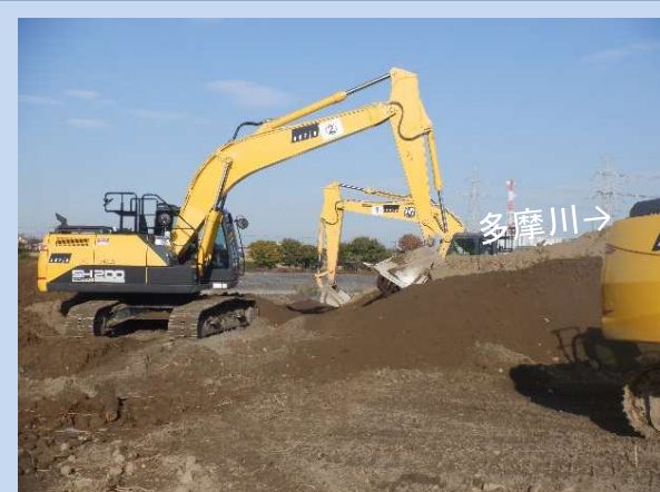
河道を掘削しています。 (令和6年11月)
