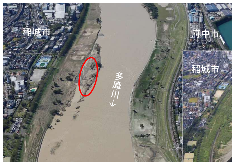
令和元年東日本台風の状況
