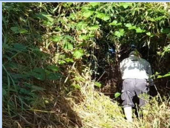
工事に入る準備をしています。 (令和6年9月)
