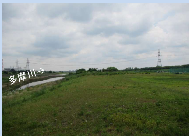
工事着手前 (令和6年8月)
