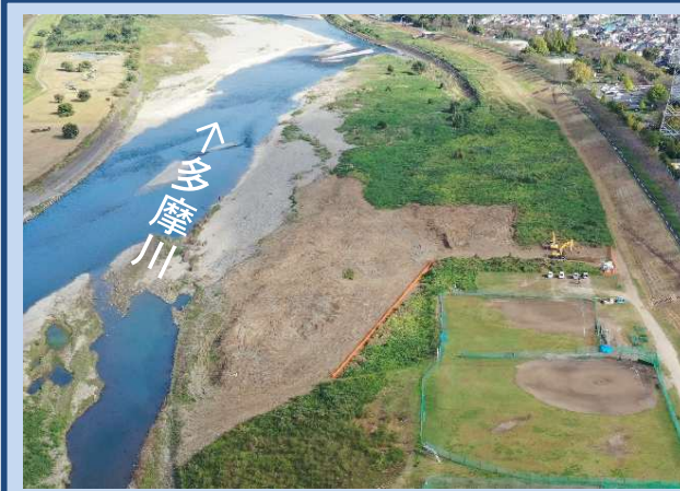
工事用道路を整備しています。 (令和6年10月)
