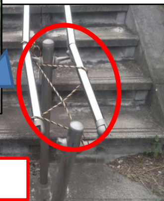
手すりの応急対策
