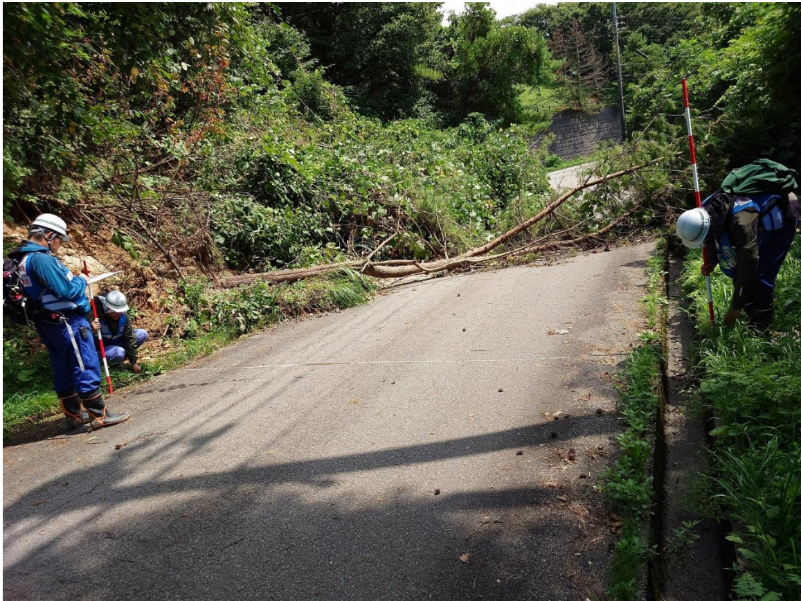
被災状況調査③
