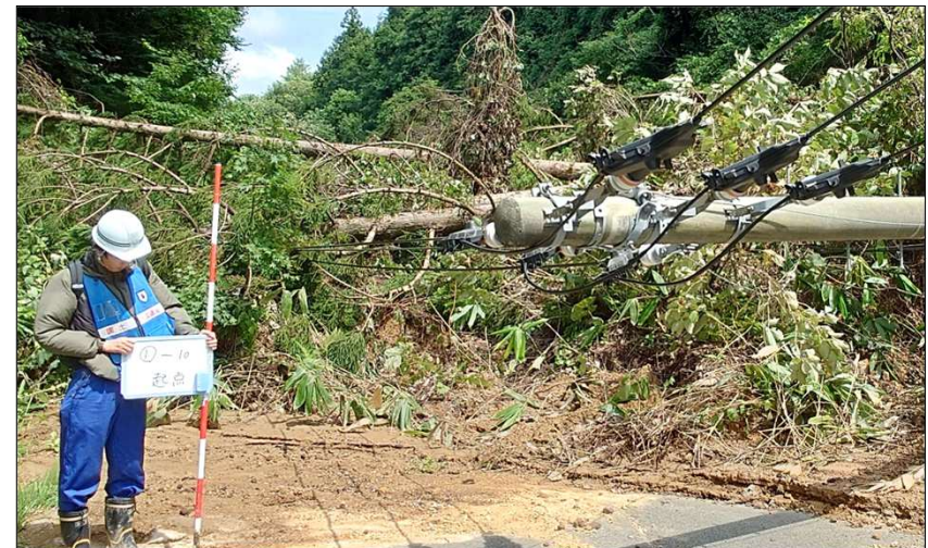
被災状況調査班(道路班)
