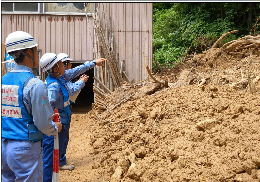
被災状況調査(山形県鮭川村)
