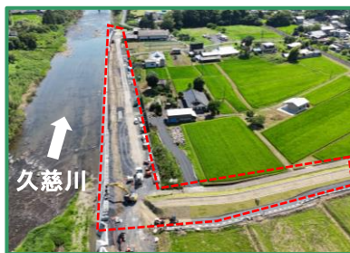
工事箇所の全景（上流から）
