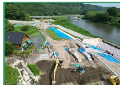
堤防盛土を行っています
