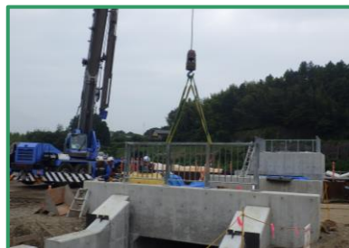
樋管の整備を行っています
