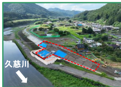
工事箇所の全景（下流から）
