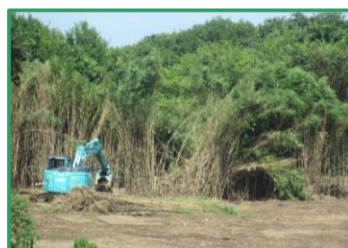
伐採作業を行っています
