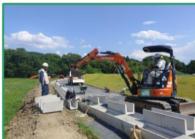
堤脚水路の整備を行っています
