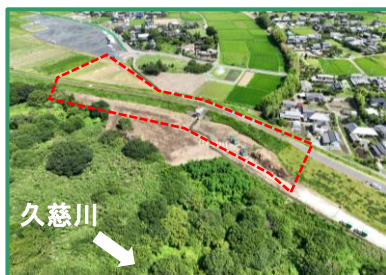
工事箇所の全景（下流から）
