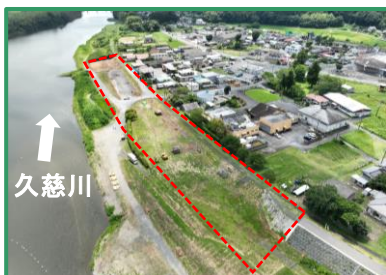
工事箇所の全景（下流から）
