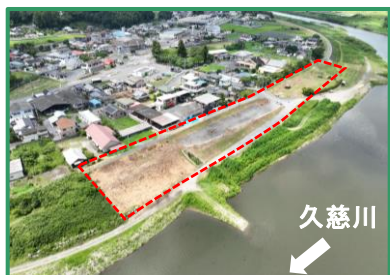
工事箇所の全景（下流から）
