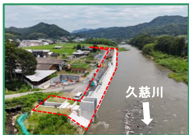
工事箇所の全景（下流から）
