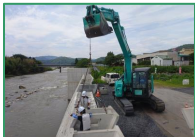
護岸ブロックの整備を行っています
