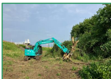
伐採作業を行っています
