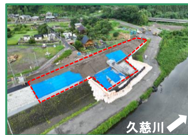
工事箇所の全景（上流から）
