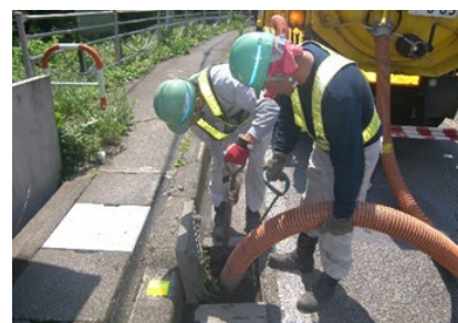
④道路排水柵の清掃
