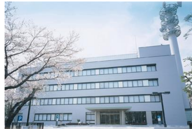
相武国道事務所
