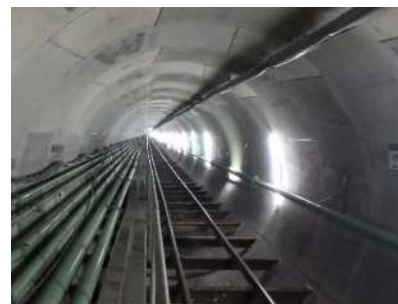
トンネル内部
