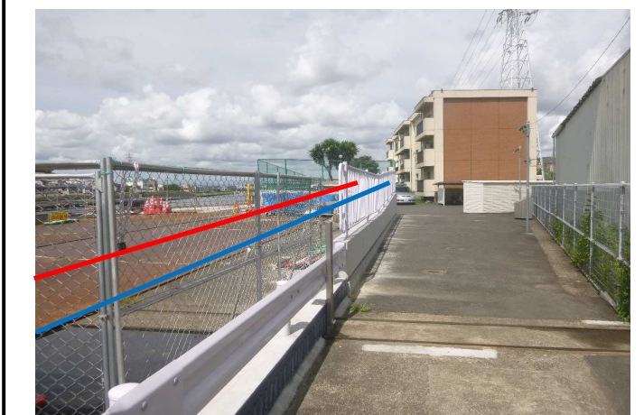
⑥敷地入り口 (橋梁の掛け替え工事で 敷地の一部を貸与)
