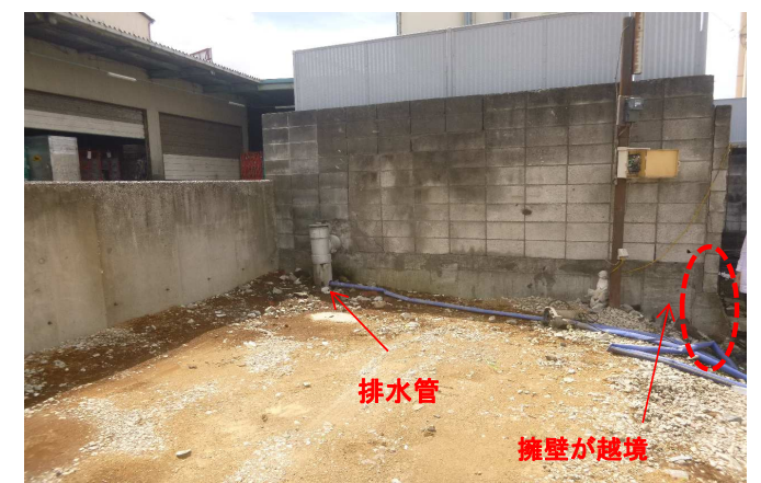
④受水槽擁壁部
