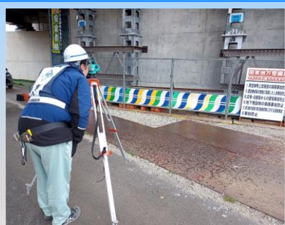
降下設備の沈下量確認
