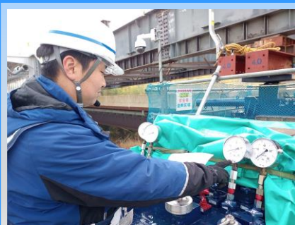
ポンプユニットの反力確認
