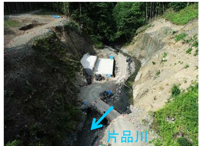
片品川 右岸側本体コンクリートの一部を打設
