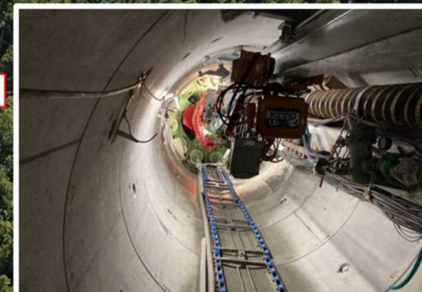
黒川導水路施工状況(R4.3.10撮影)
