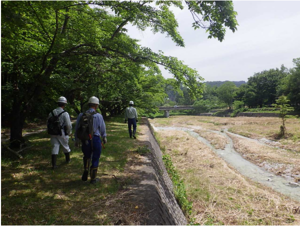
▲濁川流域の点検状況
