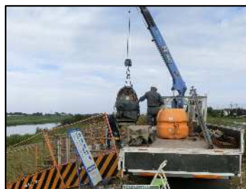
資機材の搬入・設置状況
