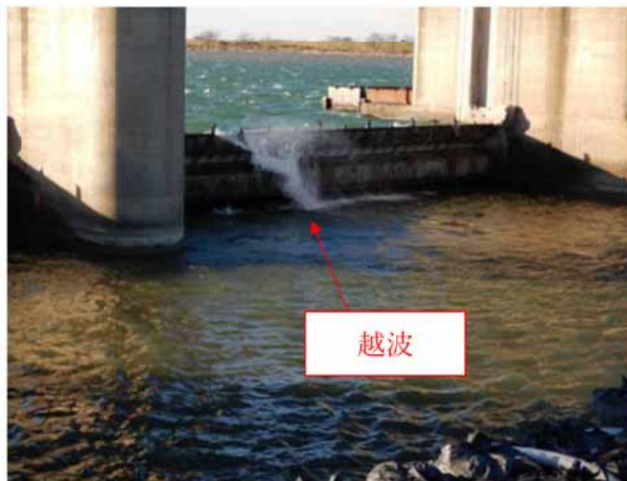
利根大堰左岸の越波と水たまりの状況
