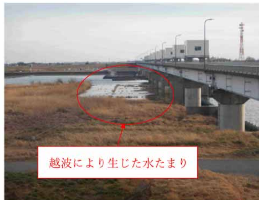
利根大堰左岸の越波と水たまりの状況
