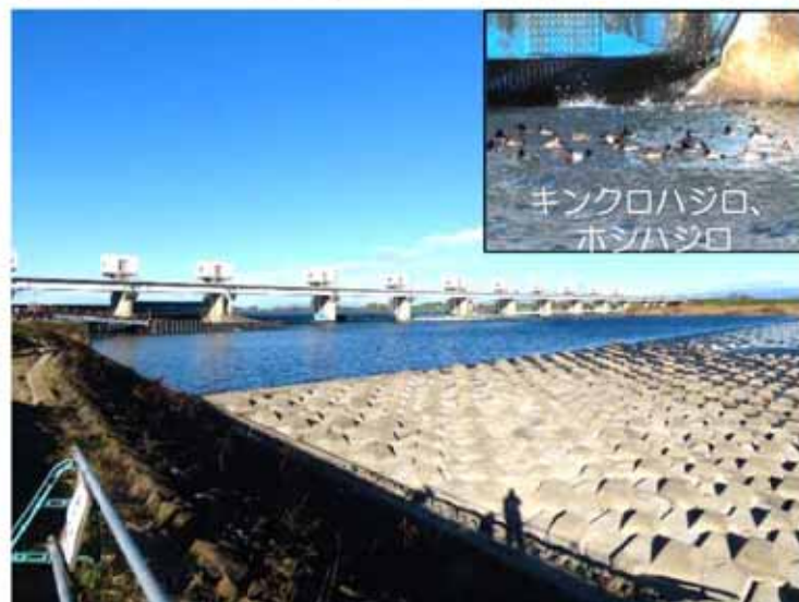
仮締切の静水域の状況 (令和4年12月18日撮影)
