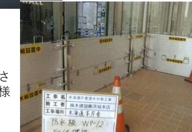
庁舎の周囲に整備された浸水防止板の様子（常総市）
