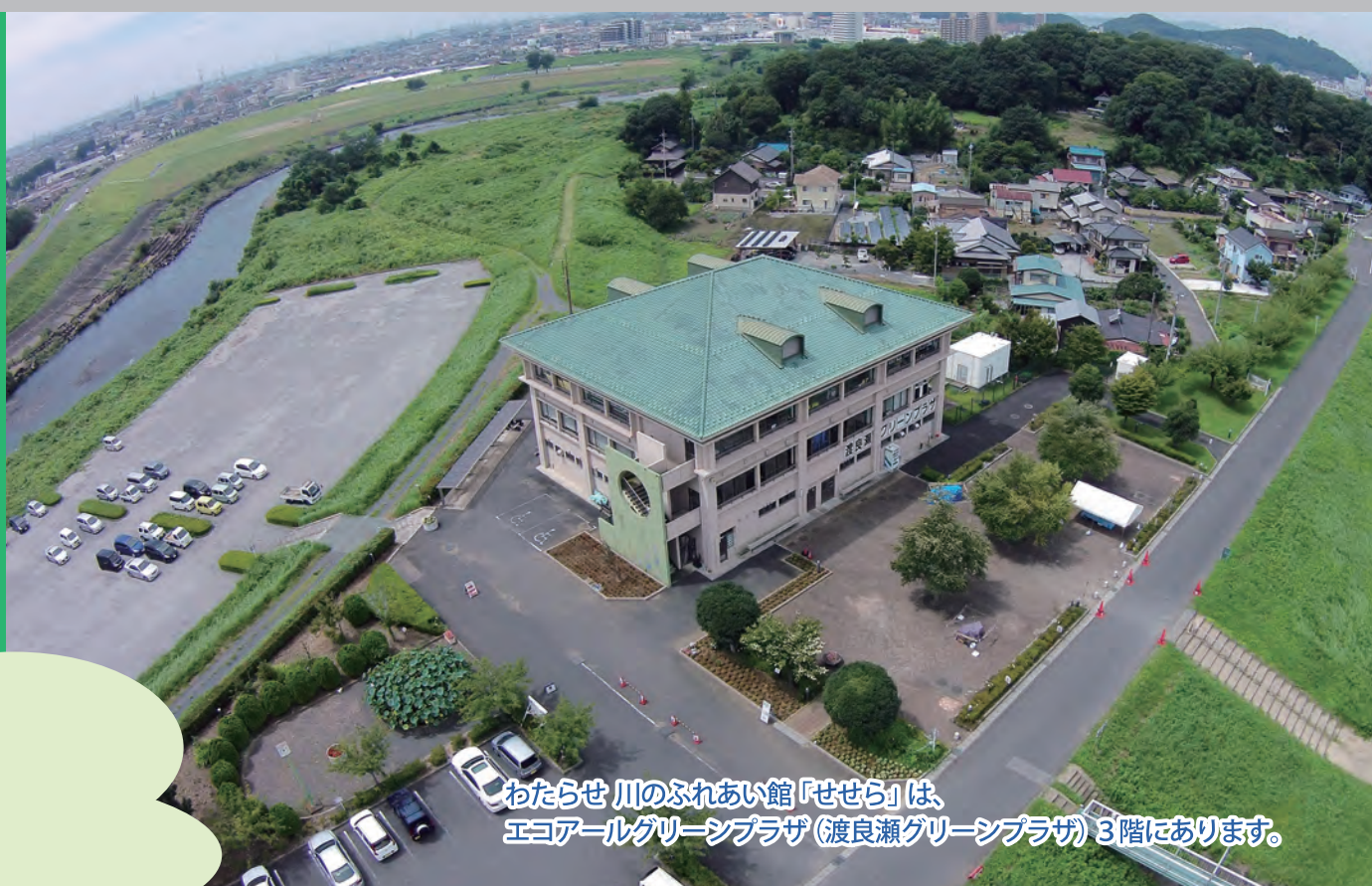
『渡良瀬橋と足利水位観測所』（足利市）
