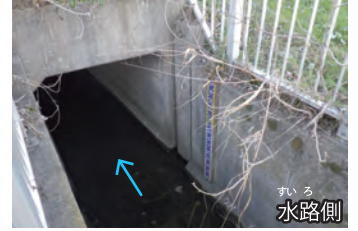
写真：下野田樋管
