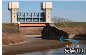
写真：矢場川水門
