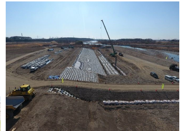
下籠谷地先低水護岸工事(施工中)
