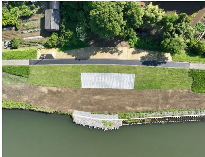
道畑排水樋管撤去工事(完成)
