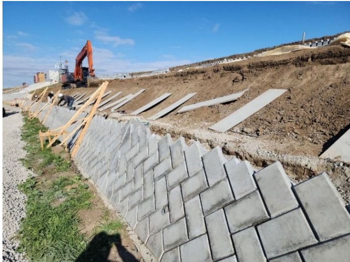
小貝川右岸東町築堤工事(施工中)
