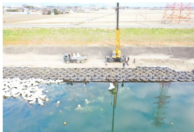
鬼怒川下流部周辺整備工事(施工中)
