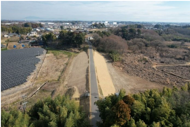
鬼怒川右岸板戸井地先河岸補修外工事(完了)
