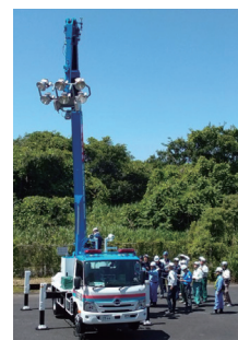
照明車概要説明、操作訓練
