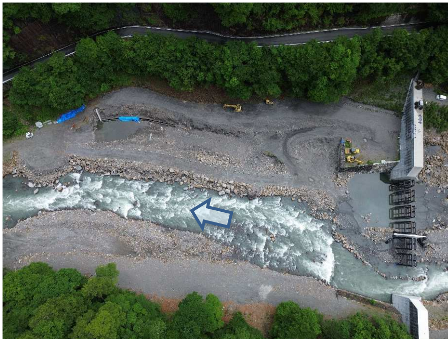
【上空より施工箇所を望む】
