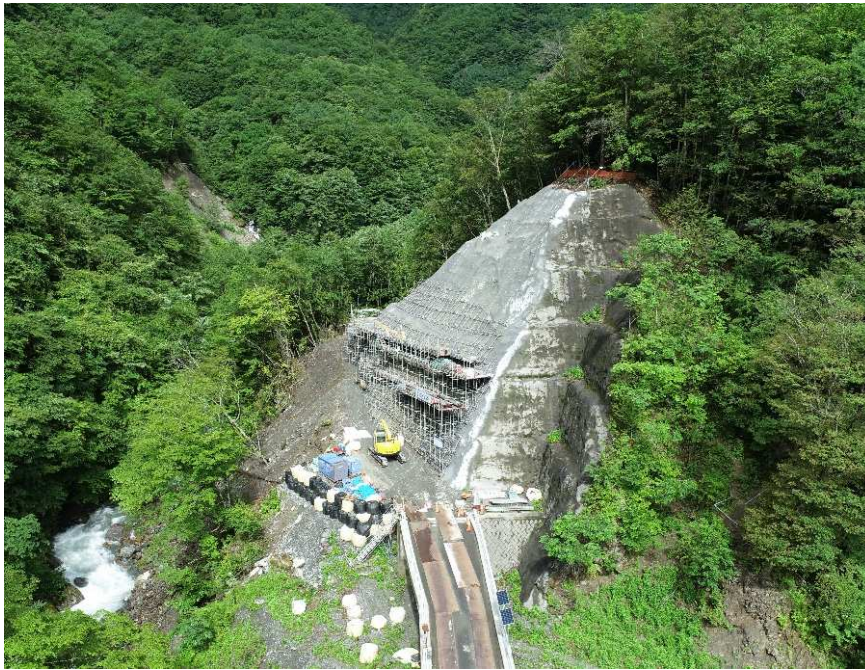
【下流側上空より施工箇所を望む】
