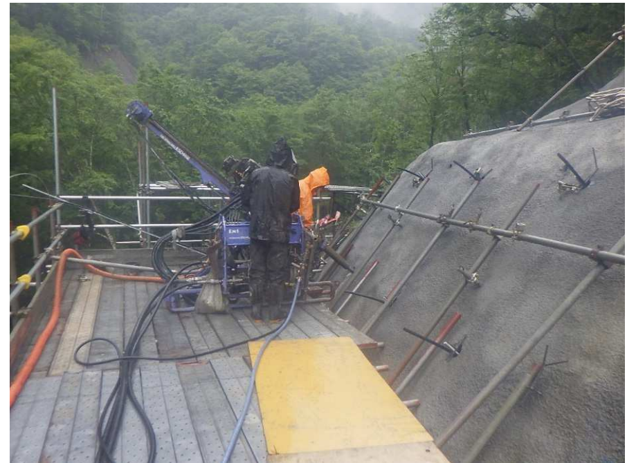
【鉄筋挿入工 施工状況】
