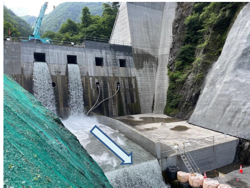
右岸下流側より望む
