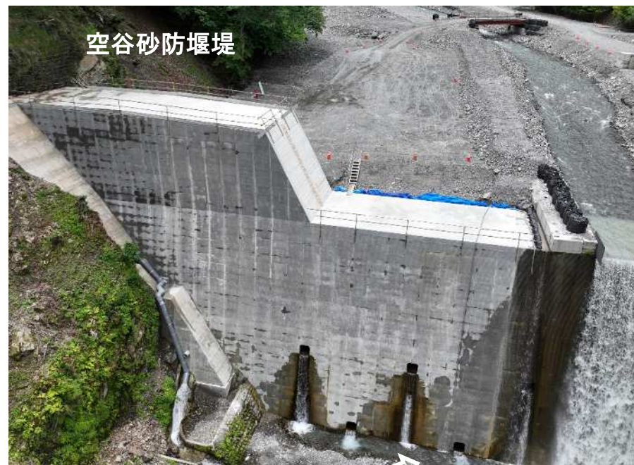
コンクリート堰堤（腹付け）施工完了
