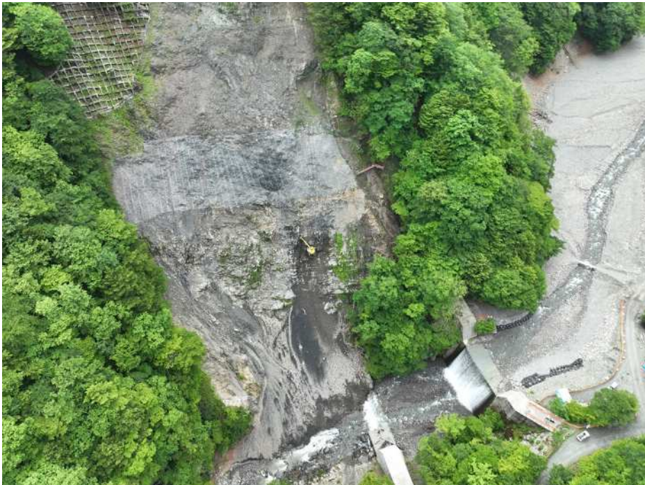
上空より施工箇所を望む
