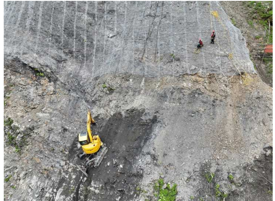
砂防土工 法面整形工
