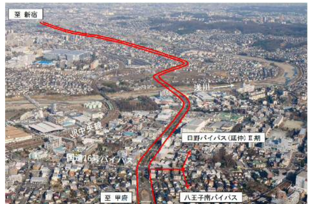
北野橋南交差点から新宿方向を望む (令和2年2月撮影)
