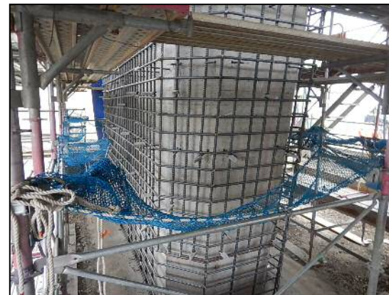
コンクリート巻立による橋脚補強
