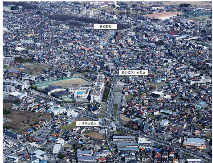
松原地区 拡幅前航空写真 (平成19年3月撮影)
