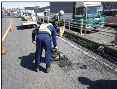
路面補修状況
