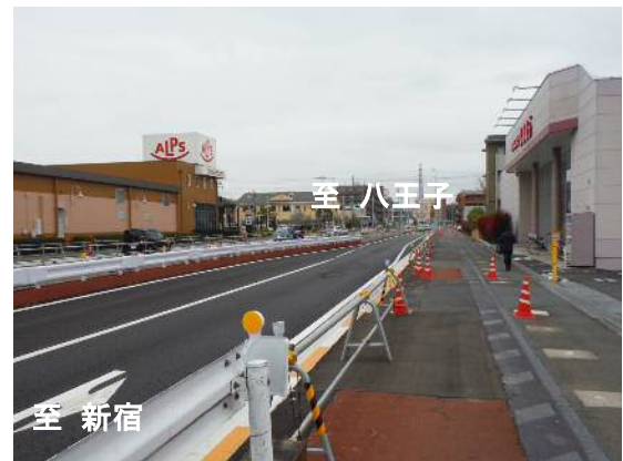
豊田南地区 歩道整備状況 (令和2年3月撮影)
