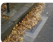
排水枡の上に落ち葉が堆積している
