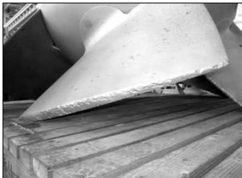
写真3 羽根車ブレードの腐食状況（先端）
