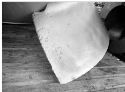
写真4 羽根車ブレードの腐食状況（表面）
