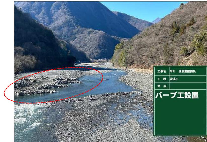
※バープエとは・・・河岸から上流側に突き出した水制工のような構造物。
