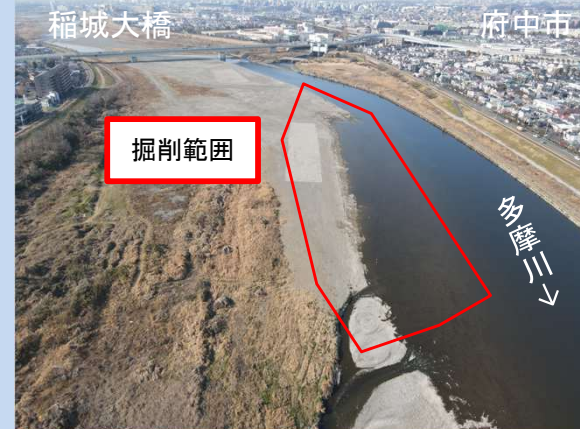
工事が完了しました。 (令和7年2月)
