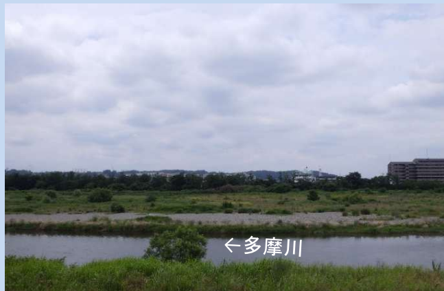
工事着手前 (令和6年6月)
