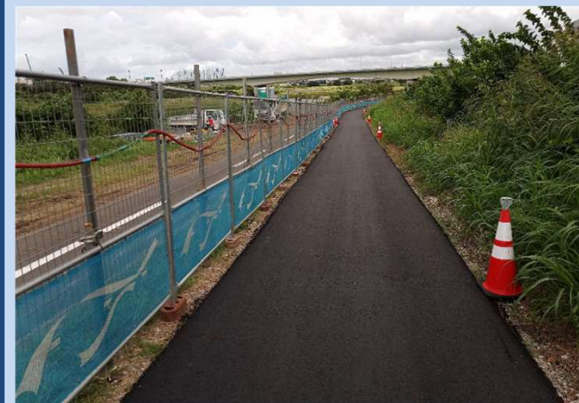
工事車両の通行を確保するため、 歩行者自転車道路を切り替えました。 (令和6年8月)
