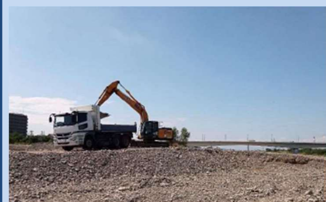
河岸の掘削を行っています。 (令和6年9月)
