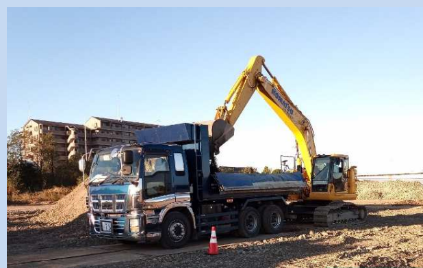
土砂を搬出しています。 (令和6年11月)
