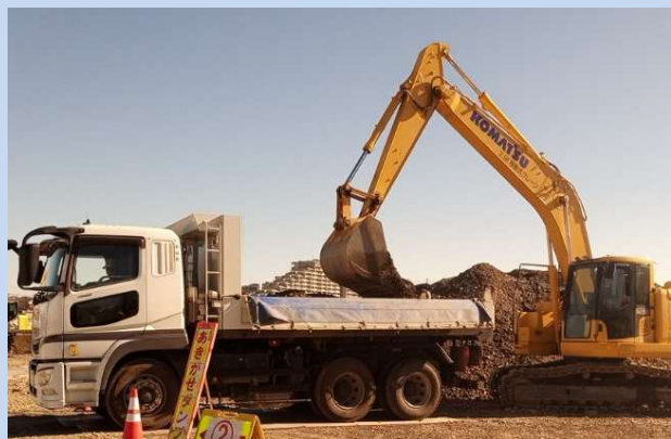
土砂を搬出しています。 (令和6年12月)
