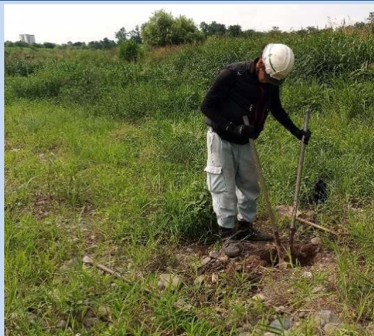
工事に入る準備をしています。 (令和6年7月)
