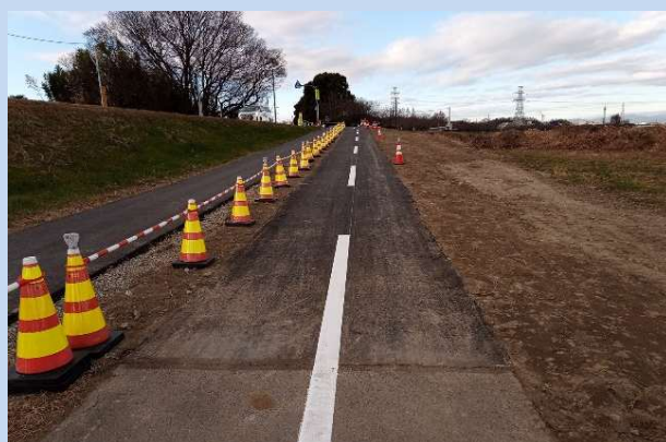
歩行者自転車道路を復旧しました。 (令和7年1月)
