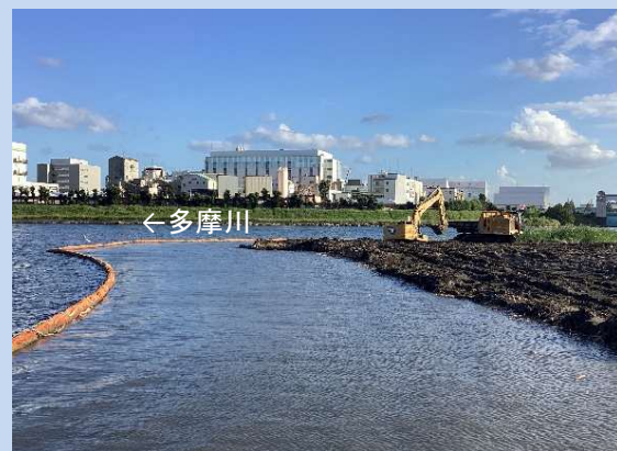
河道を掘削しています。 (令和6年9月)
