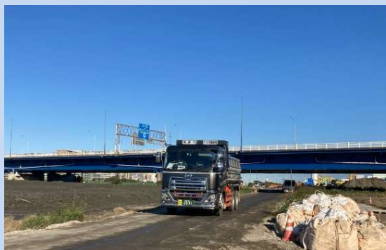
分別した土砂を運搬しています。 (令和6年12月)
