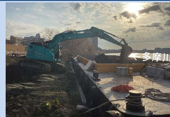
土砂を積み込み、運搬しています。 (令和7年2月)
