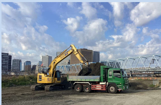
土砂を積み込み、運搬しています。 (令和7年1月)
