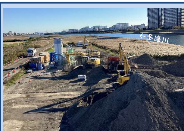
土砂分別を行っています。 (令和6年11月)
