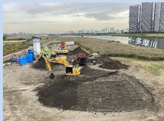
土砂分別を行っています。 (令和6年10月)
