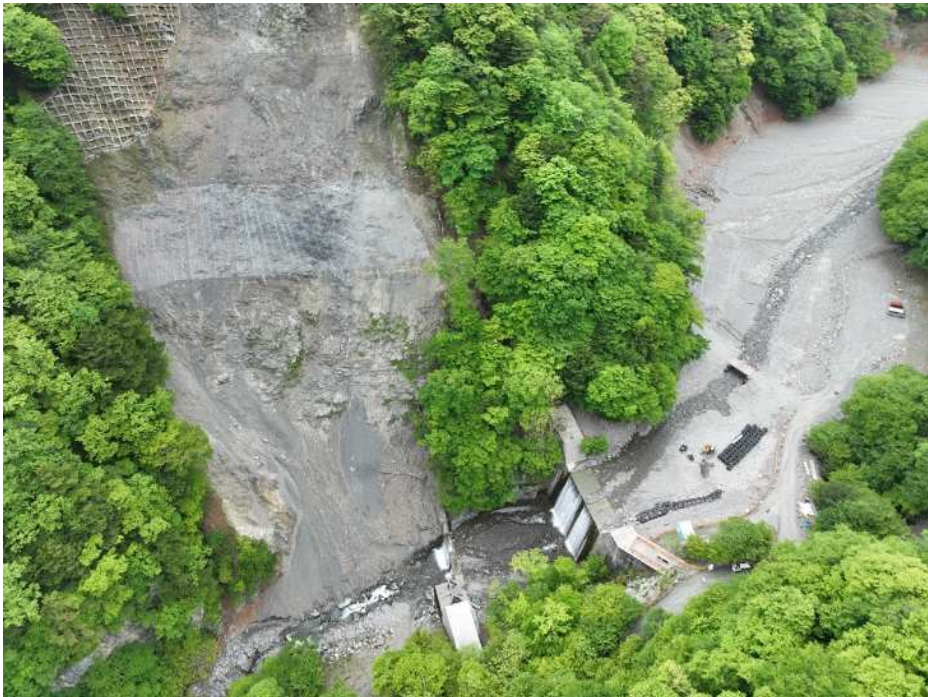
上空より施工箇所を望む
