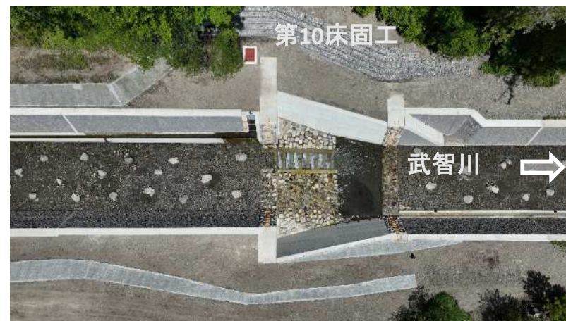
↑ 上空より施工箇所（第10床固工付近）を望む
