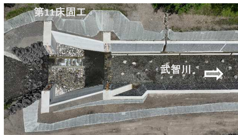
↑ 上空より施工箇所（第11床固工付近）を望む
