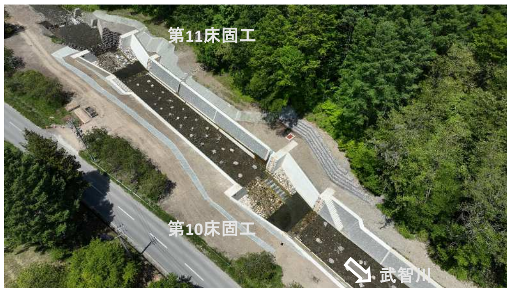
右岸上空より施工箇所を望む
