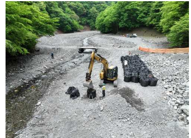
仮設工 作業ヤード整備工 大型土のう作成
