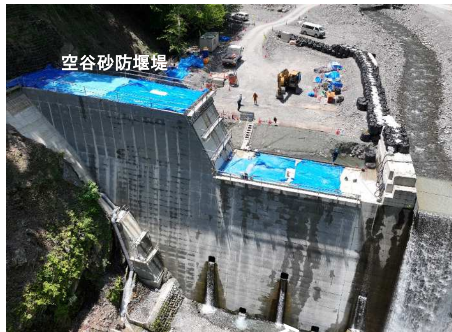
コンクリート堰堤（腹付け）施工完了
