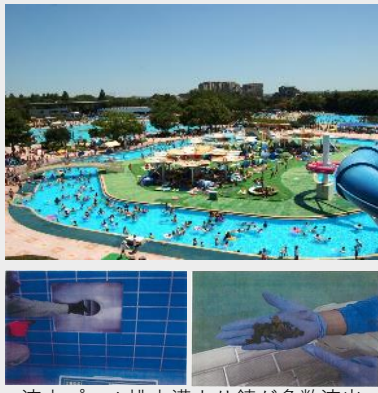
流水プール排水溝より錆が多数流出
