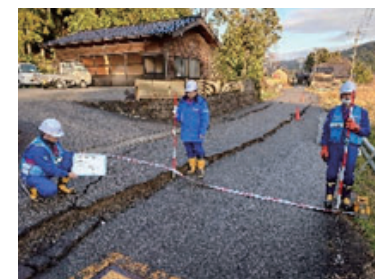
志賀町での現地調査
