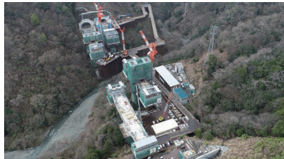
中津川橋 (松田町) の工事状況 (2024.4 撮影)
