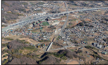
厚木秦野道路の空撮
