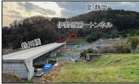
鈴川橋上部工 (令和6年3月撮影)
