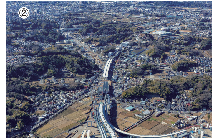
小雀高架橋付近状況（令和6年3月撮影）
